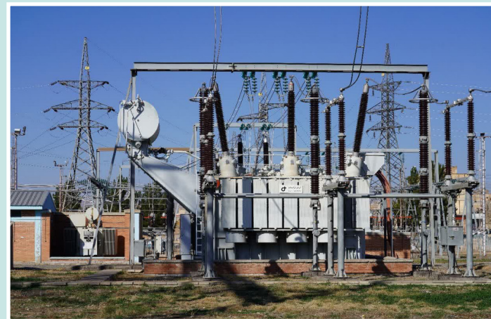
احداث خط ۴ مداره ۶۳ کیلوولت نمین در منطقه ویژه اقتصادی نمین
