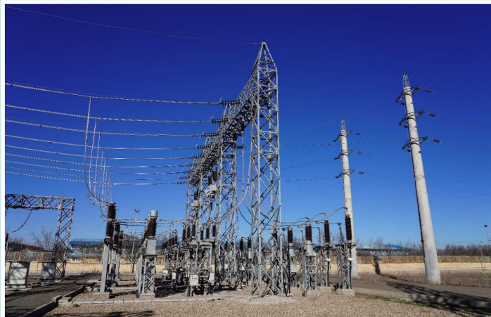
احداث دو بی‌خط ۱۳۲ کیلوولت در پست زرینه رود
