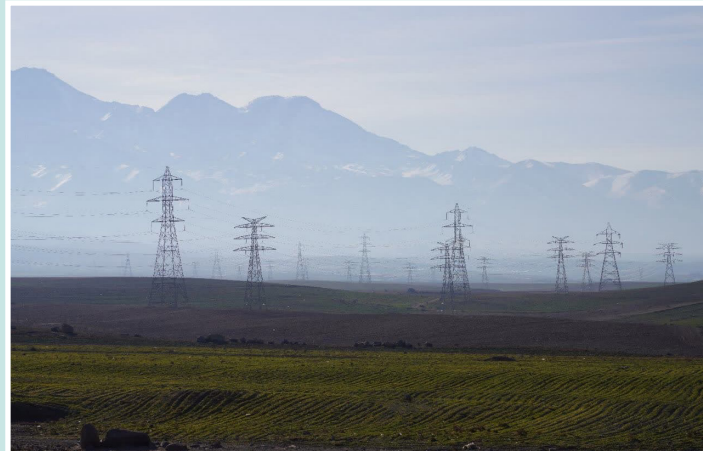
احداث خط ۴ مداره ۶۳ کیلوولت نمین - فندقلو - سلوط
