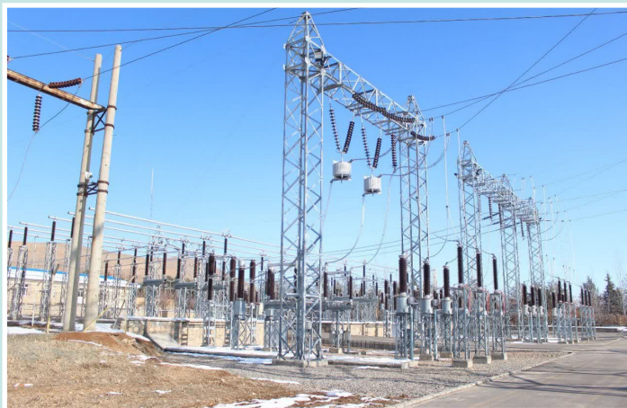
نصب ترانس دوم ۴۰۰/۲۳۰ کیلوولت در پست ۴۰۰ کیلوولت نیروگاه سیکل ترکیبی ارومیه
