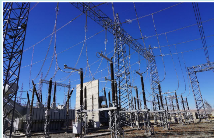
نصب و راه‌اندازی ترانسفورماتور ۶۳/۲۰ کیلوولت در پست اجیرلو
