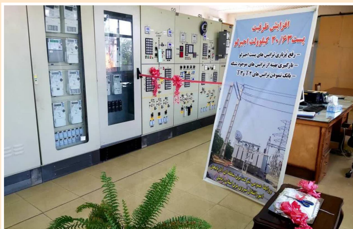
پروژه افزایش ظرفیت پست اجیرلو
