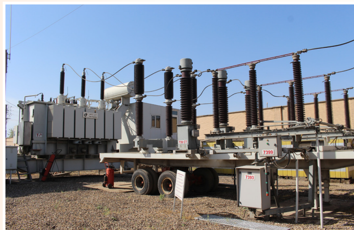
افزایش ظرفیت پست سیار ۲۰/۱۳۲ کیلوولت شهرک صنعتی شاهین بناب
