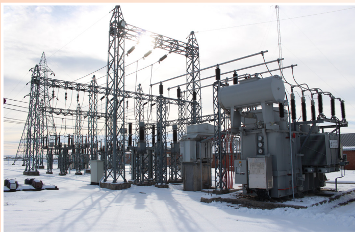
احداث یک دستگاه پست فیوزی با ترانس ۱۲/۵ مگاوات آمپر در پست ۱۳۲/۲۰ خلیفان مهاباد
