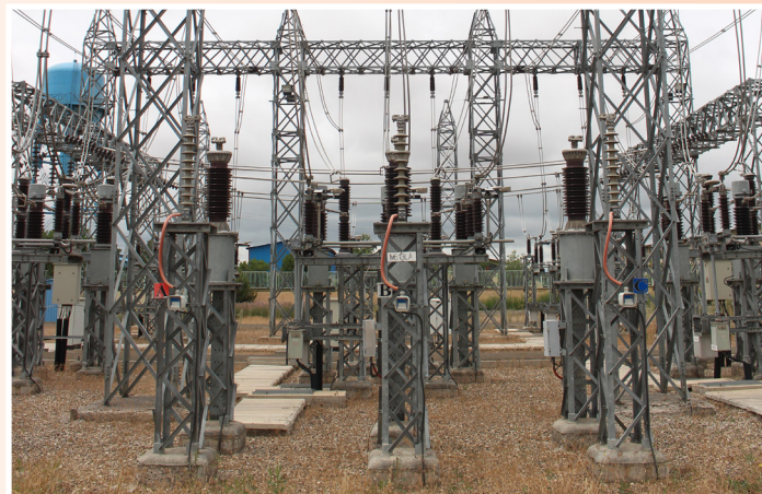
نصب و راه اندازی یک دستگاه پست سیار ۶۳/۲۰ کیلو ولت در شهرک صنعتی ۲ اردبیل (نمین)
