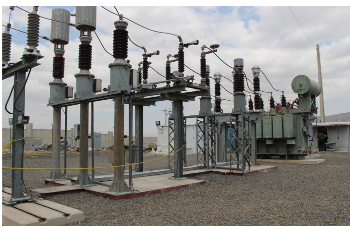
راه اندازی دو دستگاه فیدر ۲۰ کیلوولت در پست ۶۳/۲۰ کیلوولت سیلوی اهر
