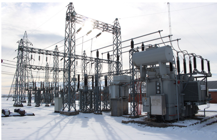
احداث یک دستگاه پست فیوزی با ترانس ۱۲/۵ مگاواولت آمپر در پست ۱۳۲/۲۰ خلیفان مهاباد
